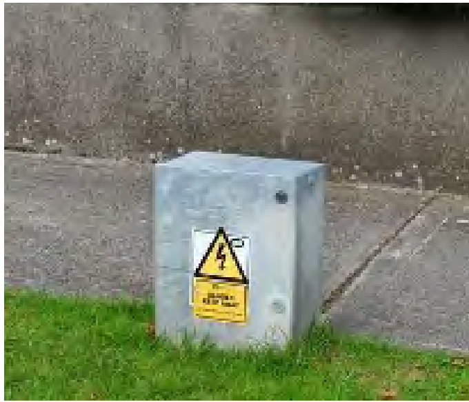
Figure 13.2 ESB Mini Pillar
